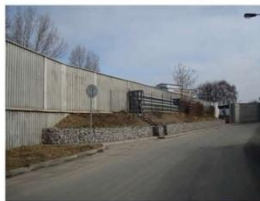
Obr. 6 Pohledově negativní protipovodňová zeď v ulici Varhulíkova (foto: Hana Babková)
